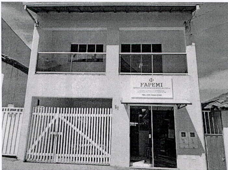
Foto 1 - Fachada do imóvel.
