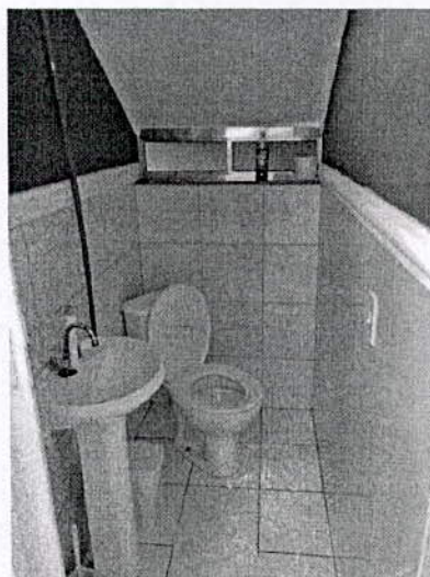
Foto 4 –Lavabo (Pavimento inferior)
