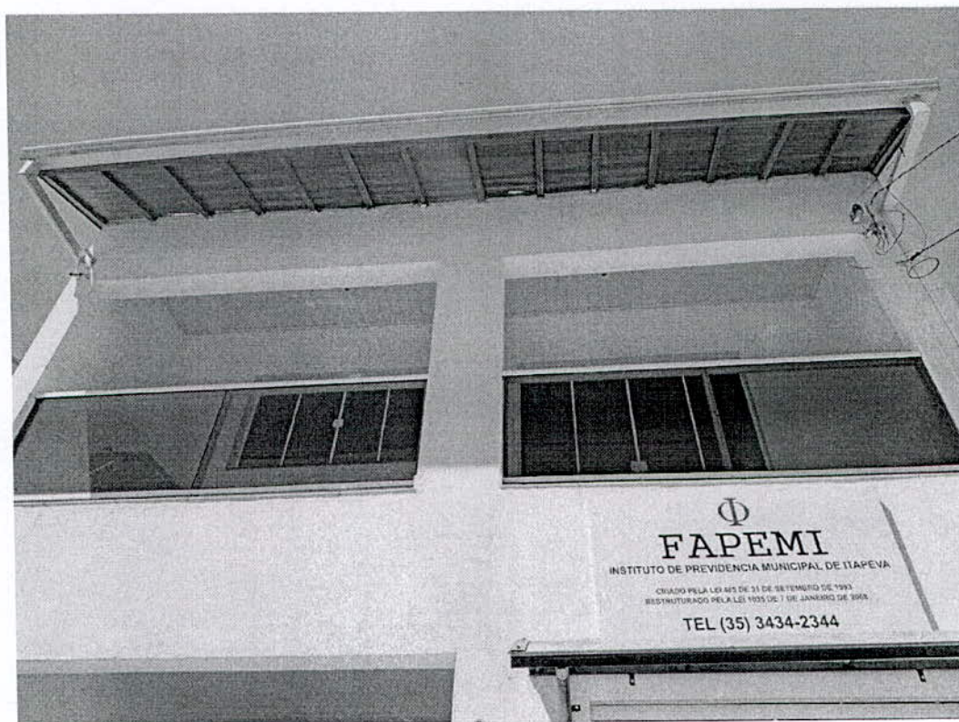
Foto fachada do imóvel – 10/11/2025
